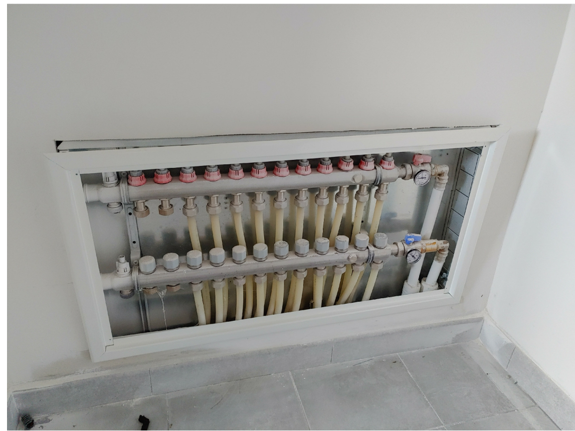
foto 9 - montare testine elettrotermiche collettori pannelli rad.
